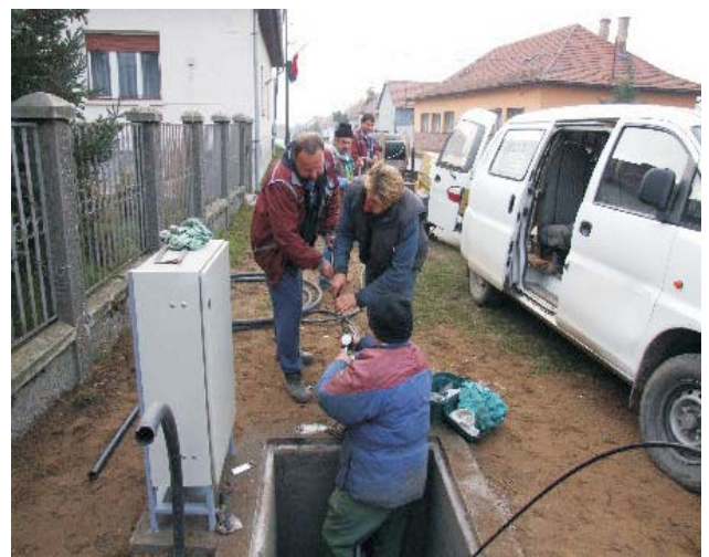
Már az optikai kábelt fektetik
